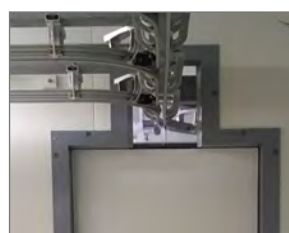
Passage de rail de manutention
